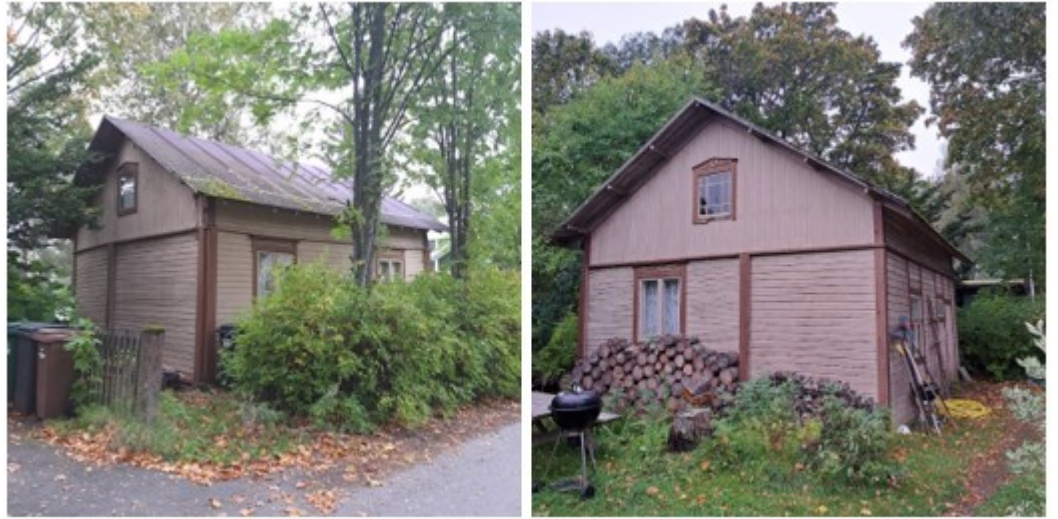
Kuva 3. Vasemmalla vanha rakennus kuvattuna Rautapellonkadulta. Oikealla näkymä tontilta. Rakennukselle on myönnetty purkulupa.
